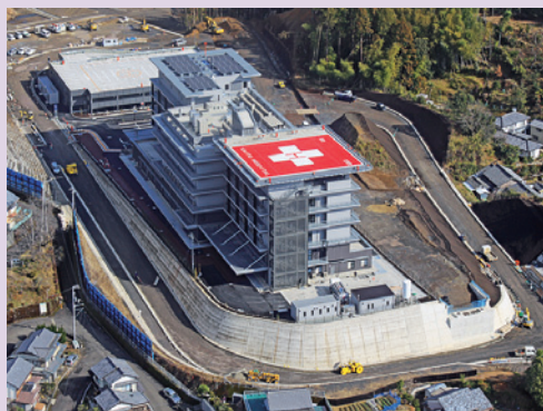
ヘリポート(病院棟屋上)
